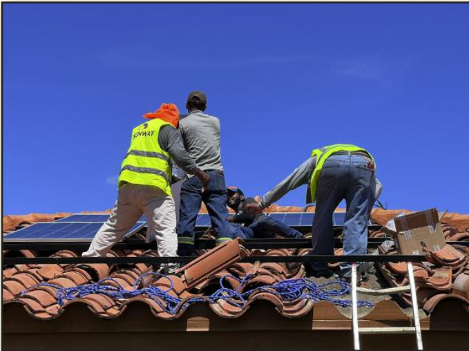
Montage der Solaranlage. 12 Panels und eine 8 KW Batterie für die Nacht
