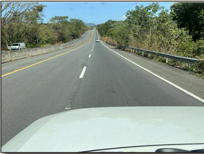
Die Autobahn hinter Santiago ist in einem hervorragenden Zustand.
