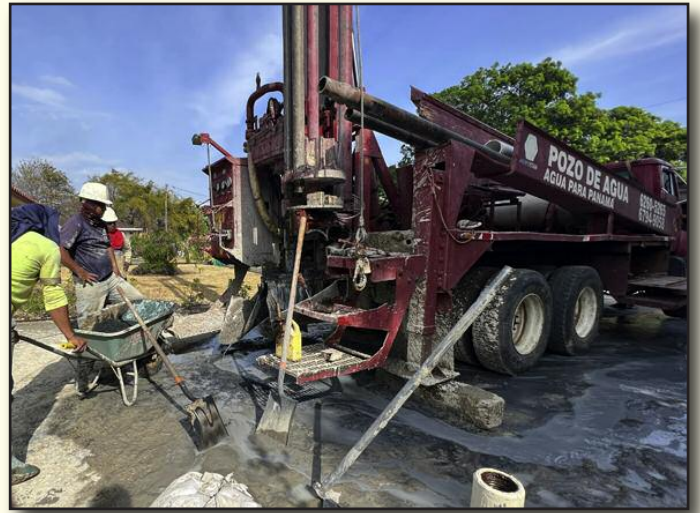
An nur einem Tag waren 50 Meter erreicht
