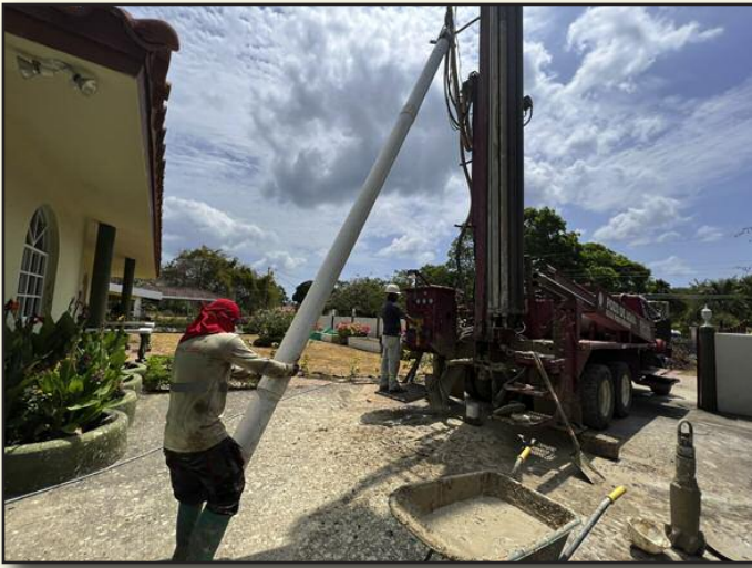
Der Brunnen wird gebohrt
